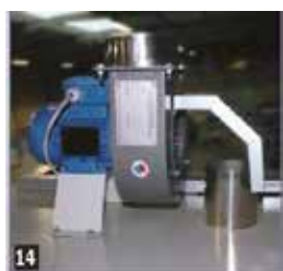
Extracteur d'aide au rejet Évacue l'air rejeté vers un système de gaine.
